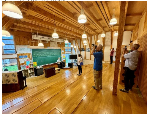
校舎内の音楽室：一般製材とBP材併用の教室構成 正面の壁は製剤をプレス接着したパネルログと同等の仕様
