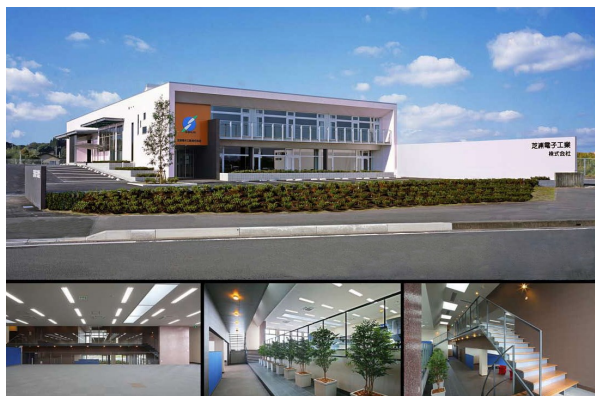
「芝浦電子工業本社新築工事」
