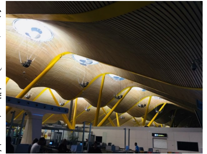
バハラス国際空港のR形天井
