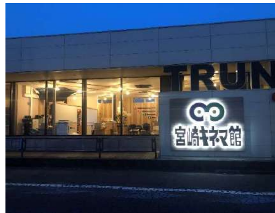
□ 宮崎キネマ館（リノベーション）…設計監理+直営施工
