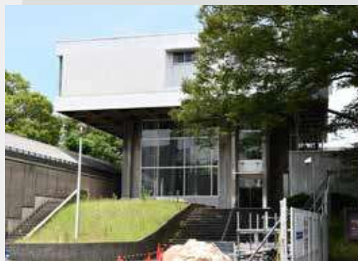
解体工事前の聖賢堂の記憶
